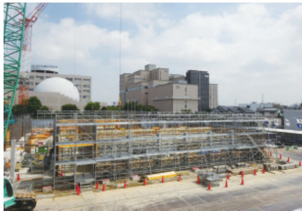
(工事が進む新市立高等学校建設現場)
